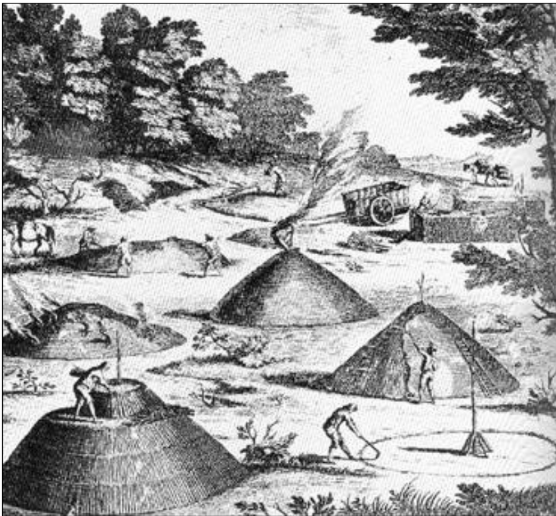
Abbildung 3.2-1 - Holzverkohlung im Meiler um 1760 nach einer Kohlezeichnung von Monceau, Paris.
